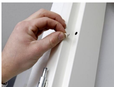
Stalen kozijn (wordt) voorzien van afdekdoopje
